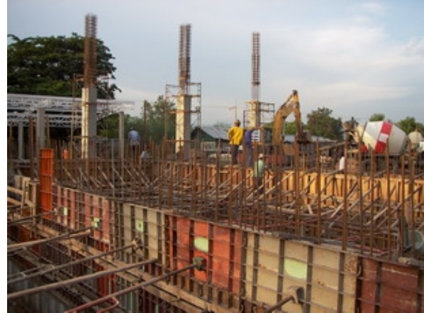
รูปที่ 8 แสดงแบบหล่อผนังบ่อและการหล่อบ่อ
