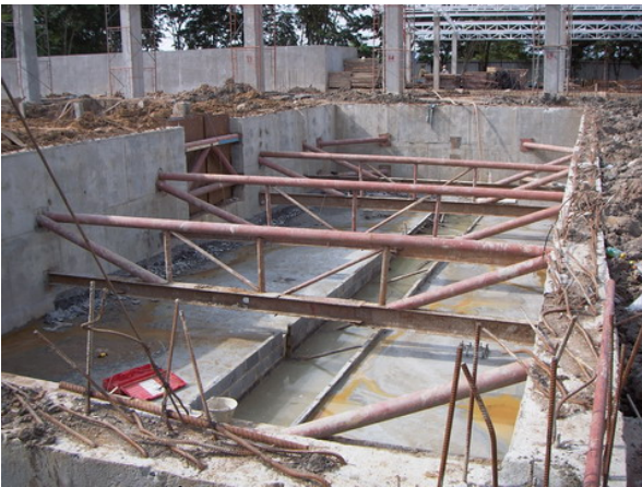
รูปที่ 12 แสดงค้ำยันเมื่อขุดถึงระดับและเทคอนกรีตหยาบ เพื่อช่วยหยุดการจม
