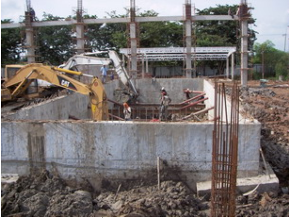
รูปที่ 11 เมื่อขุดบ่อโดยใช้ขุด(Backhoe)
