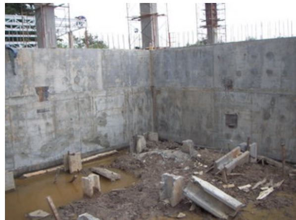
รูปที่ 9 ผนังบ่อเมื่อหล่อและถอดแบบเรียบร้อยแล้ว
