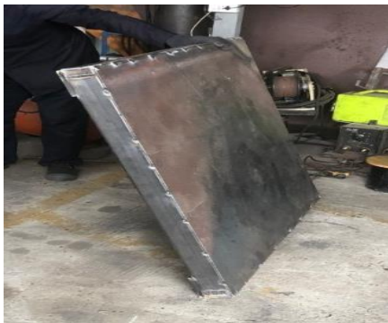
รูปที่ 4 สร้างแท่นวางถังพักน้ำและถังกรองน้ำ
