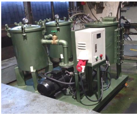
รูปที่ 12 ทดลองใช้งานโดยติดตั้งเครื่องกรองน้ำระบบน้ำหมุนเวียนงานห้องฟอสเฟตระบบมา่น้ำ
